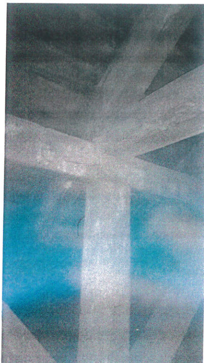
fot. 5. Widok porażonych krokwi, płatwi i podciagu
