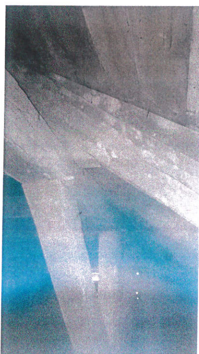
fot. 4. Widok porażonych krokwi i płatwi oraz wtórnych elementów konstrukcji: słupów i mieczy
